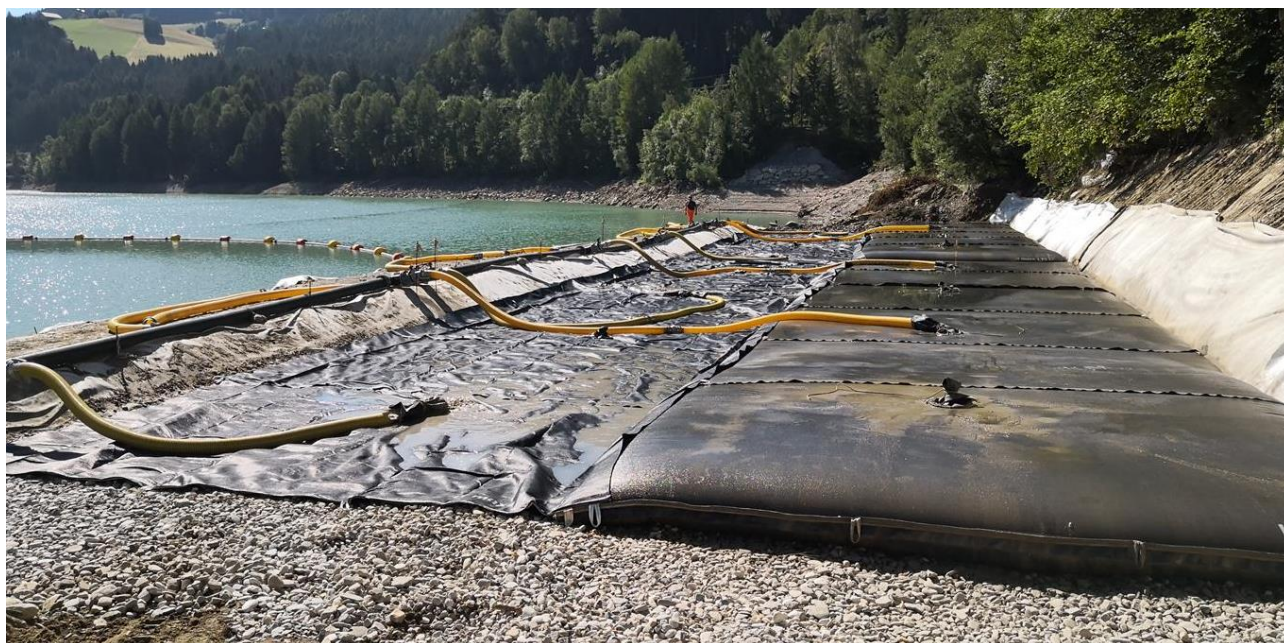
Figura 7-9: geotubi in fase di riempimento
